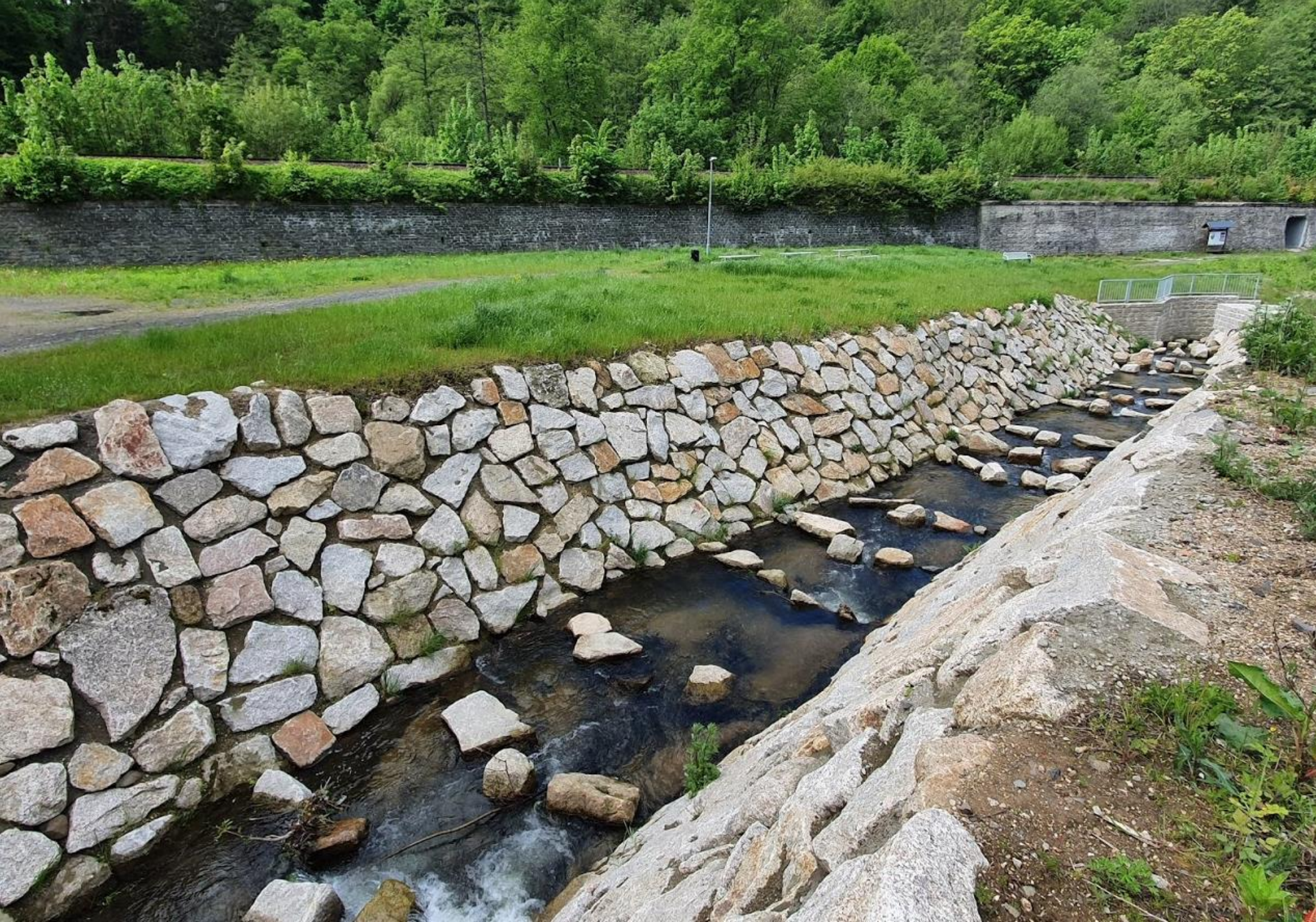
střední úsek rybího přechodu – otevřené nepravidelné lichoběžníkovité koryto
