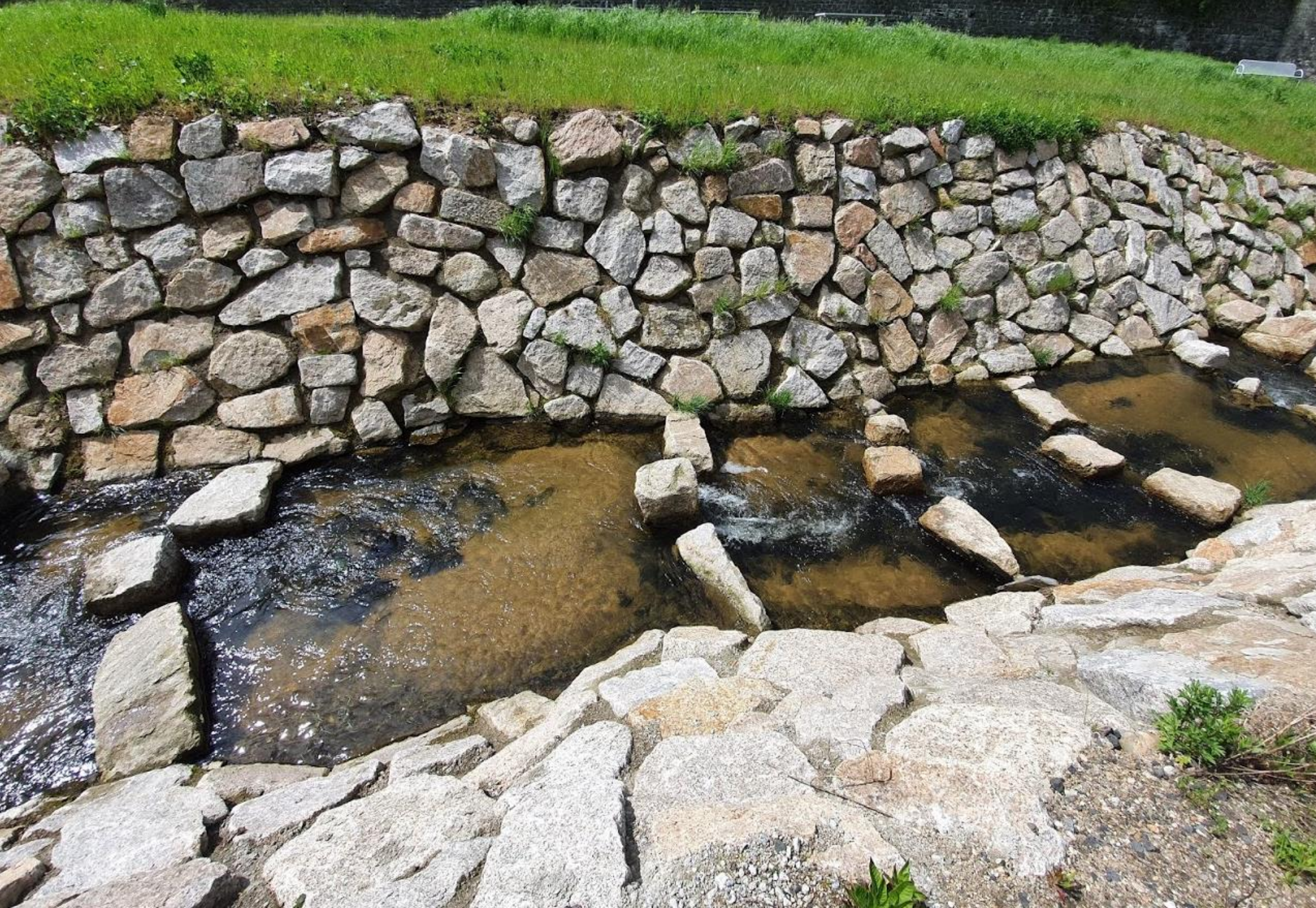
střední úsek rybího přechodu – otevřené nepravidelné lichoběžníkové koryto
