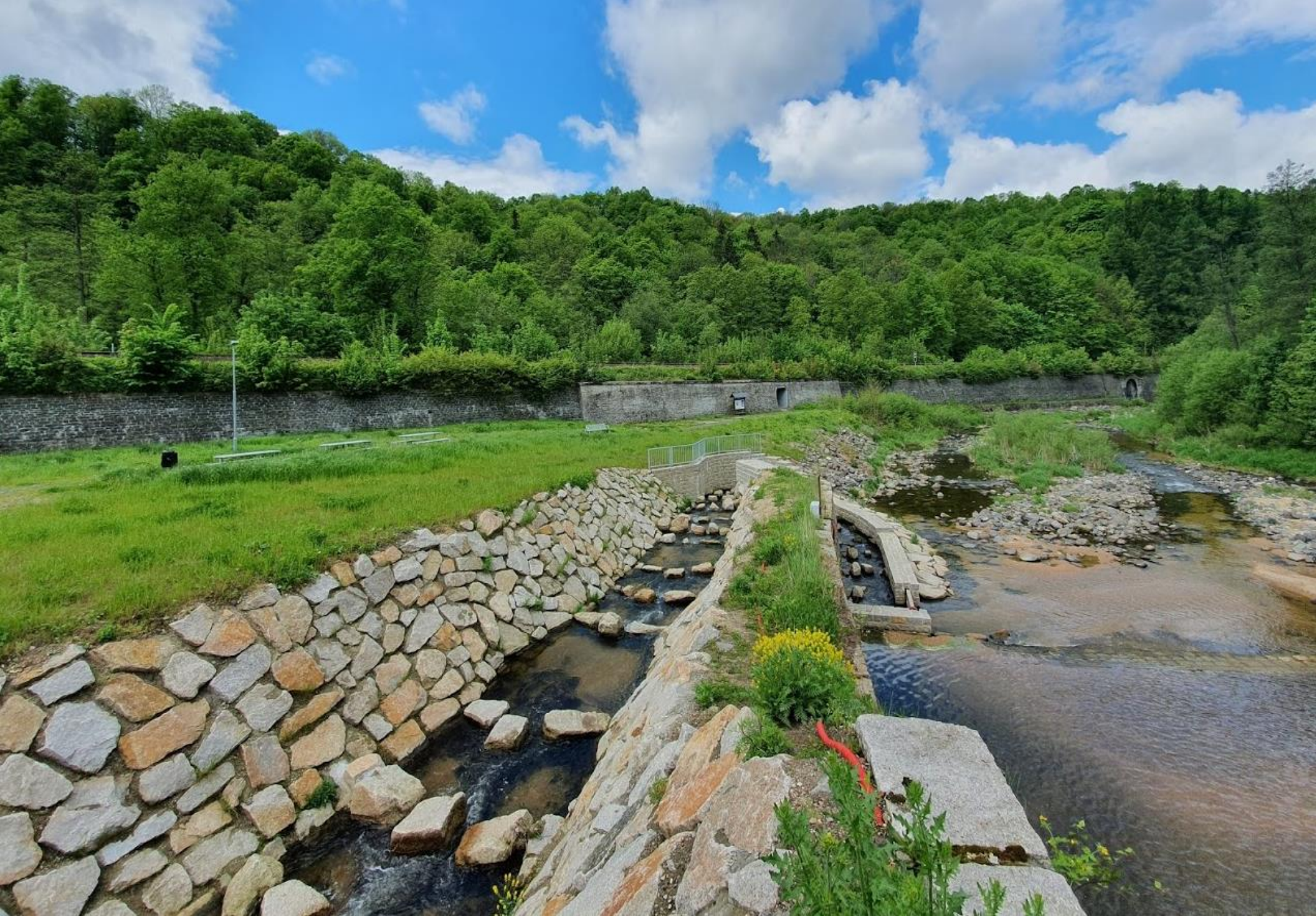
střední úsek rybího přechodu a výtok z rybího přechodu
